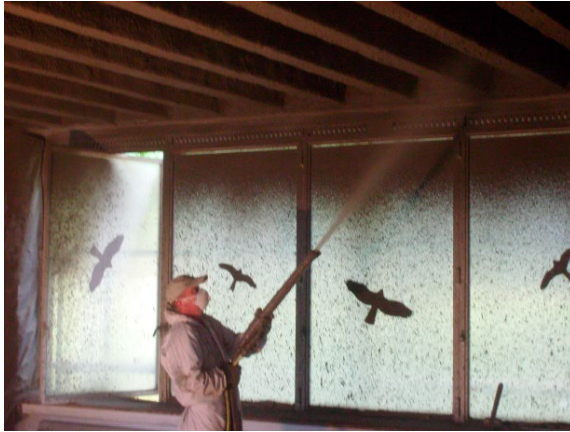
Bild 12. Aufbringen einer Spritzmörtelschicht
