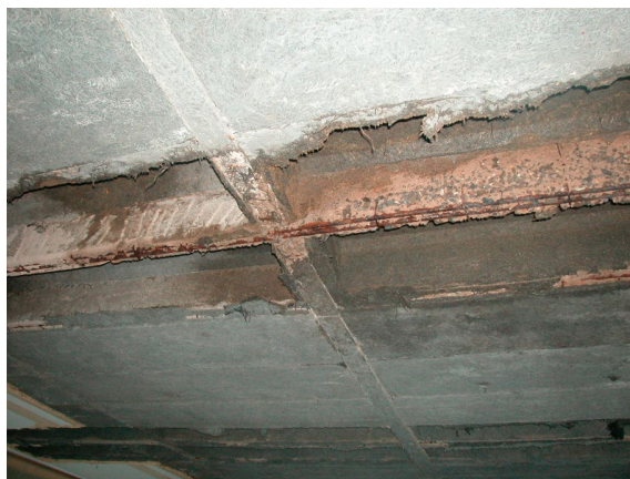
Bild 11. Rippe während dem Hochdruckwasserstrahlen
