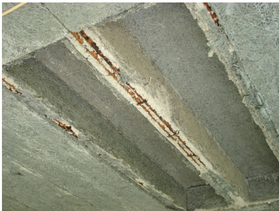
Bild 7. Rippuntersicht nach Entfernung der ersten Heraklith-Platte
