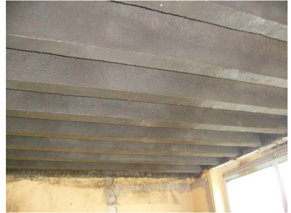
Bild 13. Rippendecke nach erfolgter Sanierung
