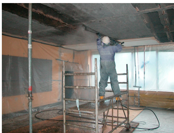
Bild 10. Hochdruckwasserstrahlen einer Deckenrippe
