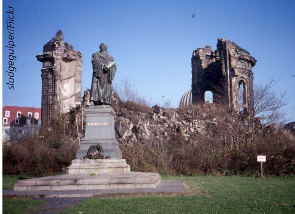
Ein Beispiel für Rekonstruktion: Die Frauenkirche in Dresden vor (November 1989) und nach dem Wiederaufbau (eingeweiht im Oktober 2005)
