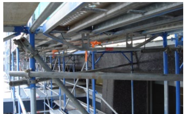
Bild 11. Gerüstkupplungen
