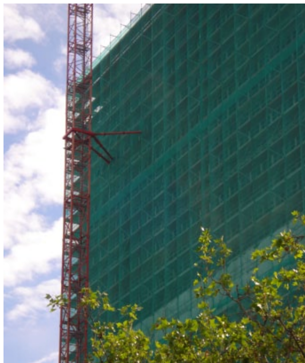
Bild 6. Foto eines ca. 84 m hohen Arbeitsgerüsts (hinter grüner Einnetzung); Foto Kretz
