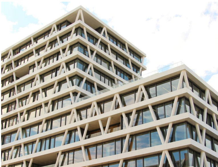
Bild 2. Das 50Hertz Netzquartier (Blickrichtung vom Hamburger Bahnhof)
